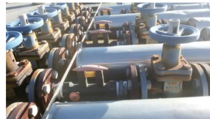
Controllo del flusso e bilanciamento idraulico dei rami
