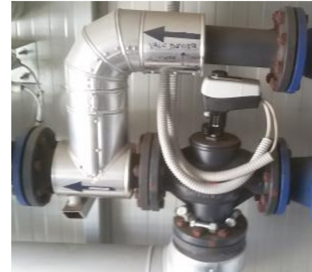
DISSIPAZIONE CON SCARICO TERMICO
