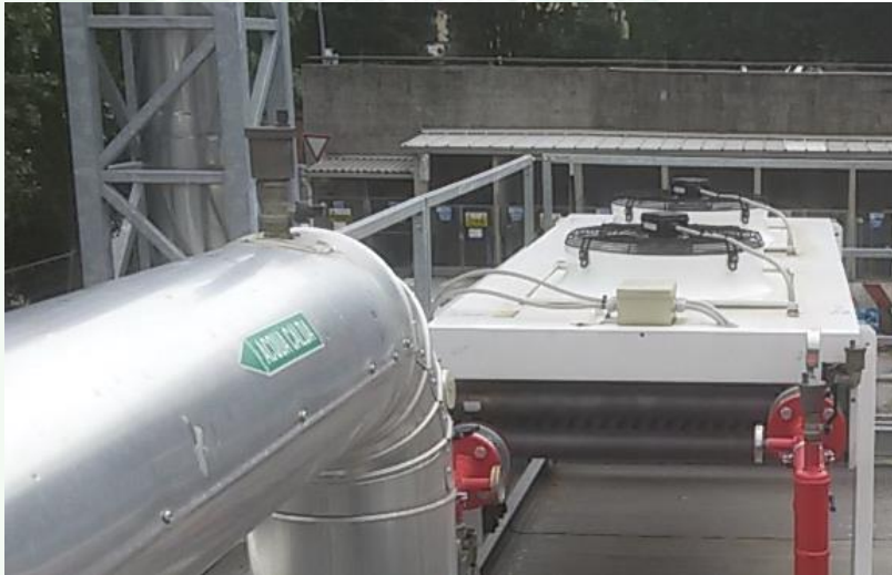
DISSIPAZIONE CON VENTILAZIONE FORZATA
