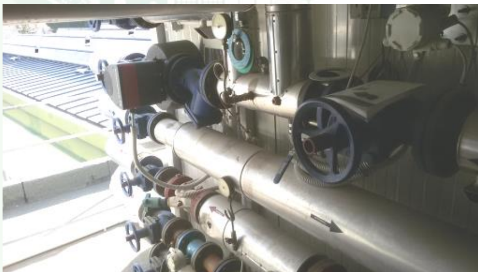
STAZIONE DI POMPAGGIO CAMPO SOLARE
