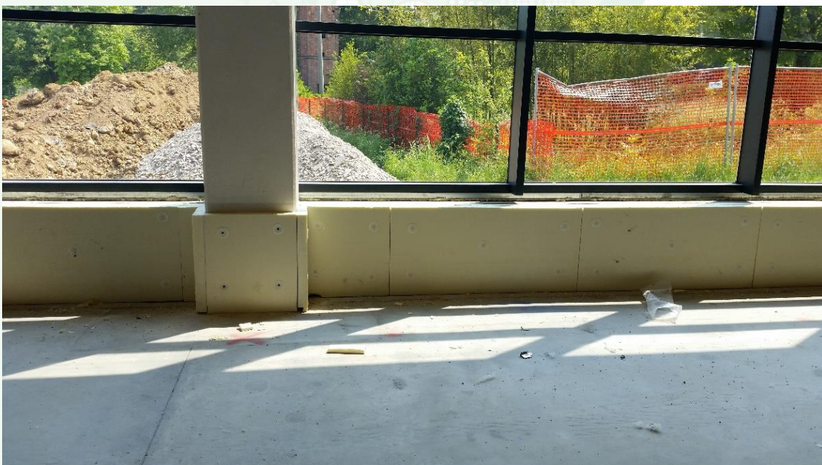
Coibentazione plenum pavimento galleggiante Verso parete controterra
