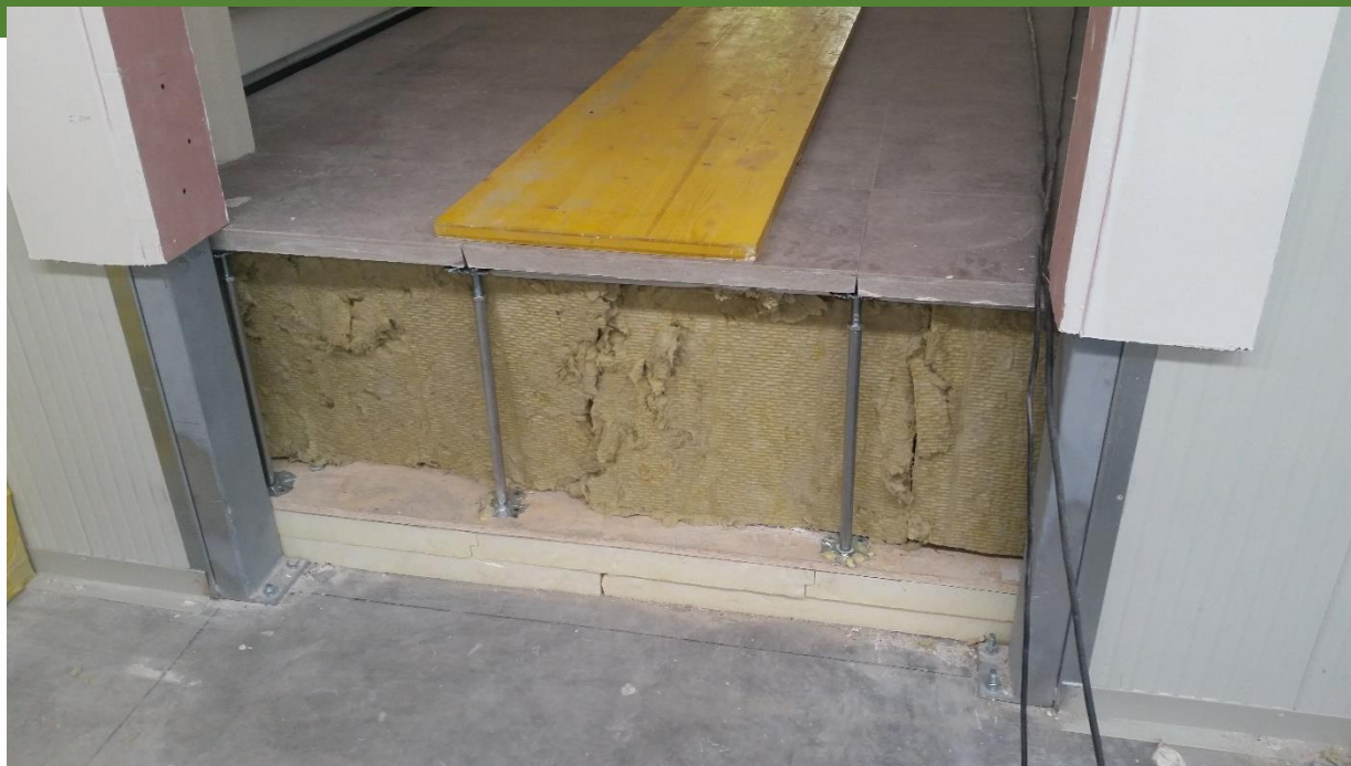
Coibentazione plenum pavimento galleggiante Verso pavimento esistente e locale magazzino
